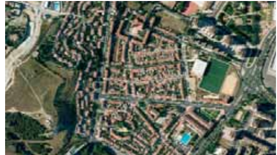
Valladolid. Plaza Eliptica – Plaza Porticada.
